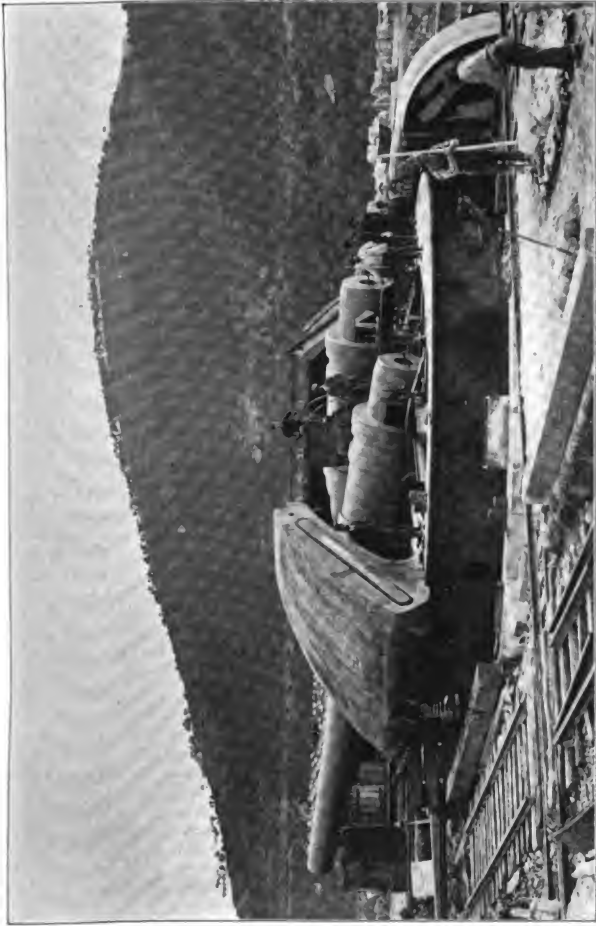
Abb. 56. Gruson'scher Panzerturm mit zwei 24 cm Geschützen im Bau.
